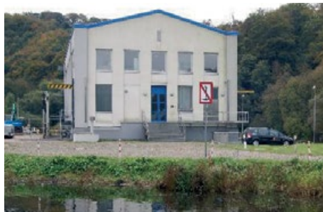
Wasserwerk Bochum Stiepel
